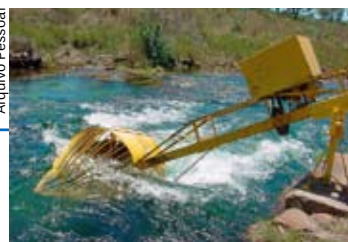
Em funcionamento: a turbina que fornece a energia da comunidade de Varadãozinho
